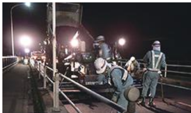
国道 362 号（当古橋）
