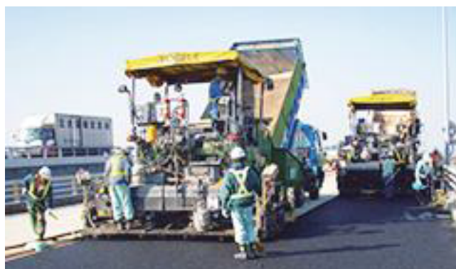
国道 1 号（新天竜川橋）
