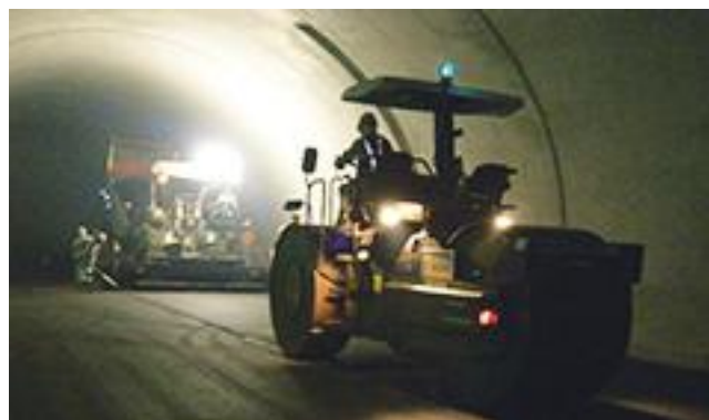
三遠南信自動車道 (三遠トンネル)
