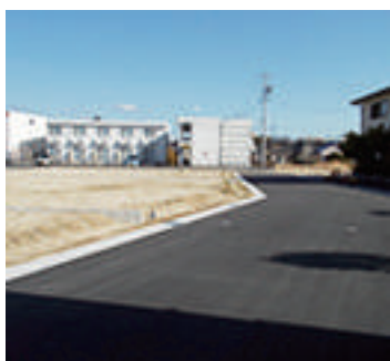
宅地造成 (after)
