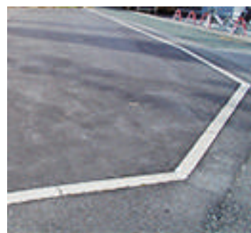
防草対策 (after)
