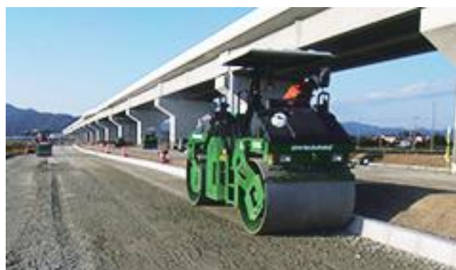
国道 23 号 ( 梅敷地区 )
