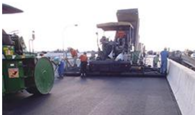
東三河環状線 (白鳥高架橋)
