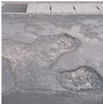
ポットホール・ 骨材飛散
